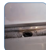
Cuentan con desagüe en el interior de la cámara.
